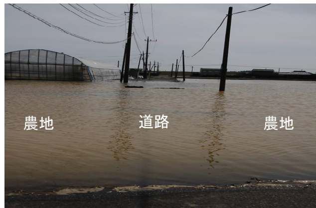
写真5 稲敷市における液状化による冠水（2011/3/12稲敷市撮影、35. 915175N, 140. 487447E）
