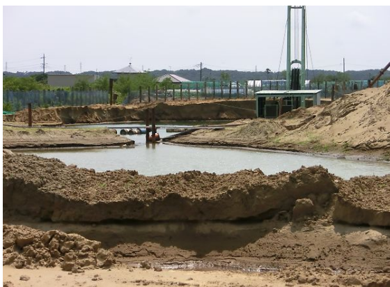
写真4 砂利採取の状況（2011/7/25撮影、神栖市太田新町3丁目 35. 835947N, 140. 725348E）
